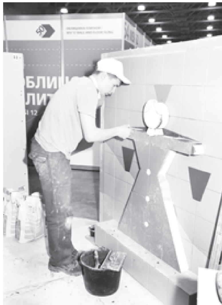
Виртуозы плиточного дела на финишной черте
