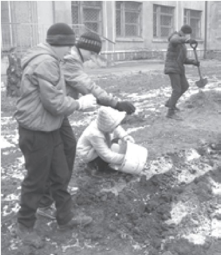
И в холод, и в жару идут работы на земле
