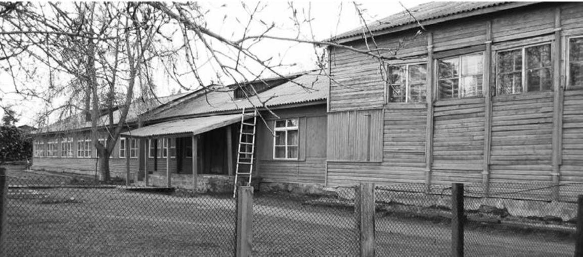
Здание школы до пожара
